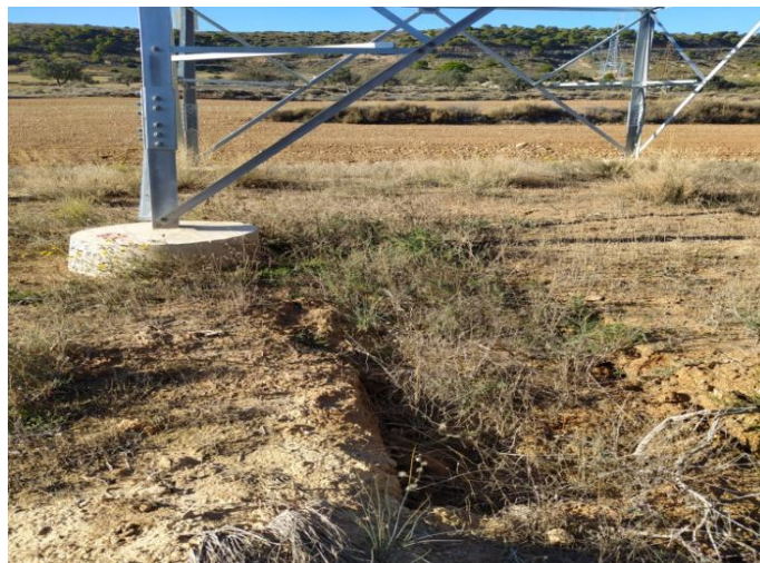
Imagen 3: Apoyo AP61, reguero direccionado al apoyo.
