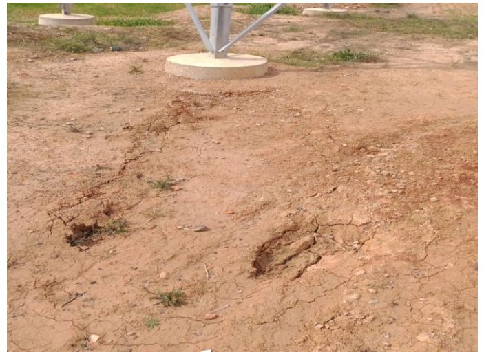
Imágenes 8 y 9: Apoyo AP76, hundimiento del suelo situado en el entorno de la base del apoyo.
