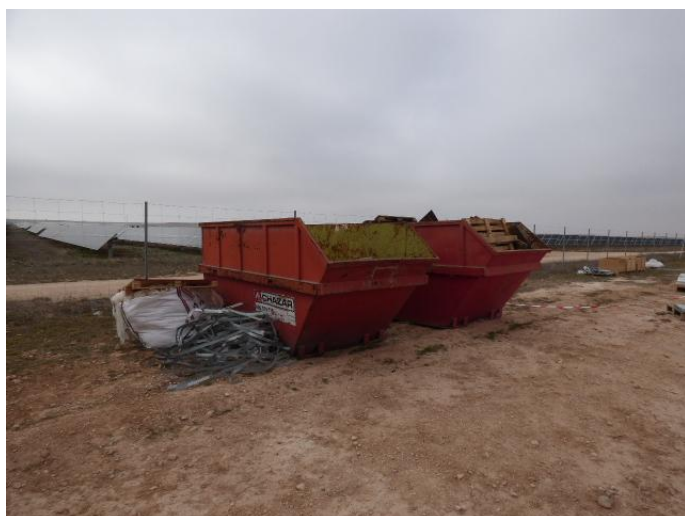
Imágenes 19 y 20: Contenedor de residuos no peligrosos sin el etiquetado correspondiente (izquierda). Residuos de obra depositados fuera del contenedor (derecha).
