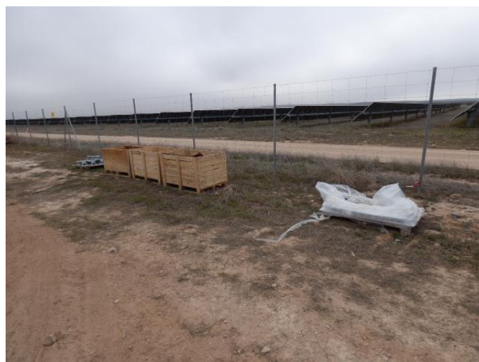
Imágenes 19 y 20: Contenedor de residuos no peligrosos sin el etiquetado correspondiente (izquierda). Residuos de obra depositados fuera del contenedor (derecha).
