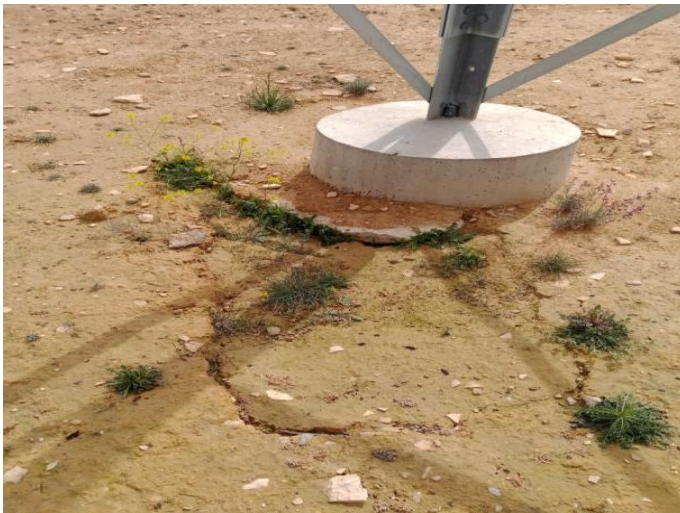
Imágenes 6 y 7: Ligero hundimiento del suelo adyacente al apoyo AP74
