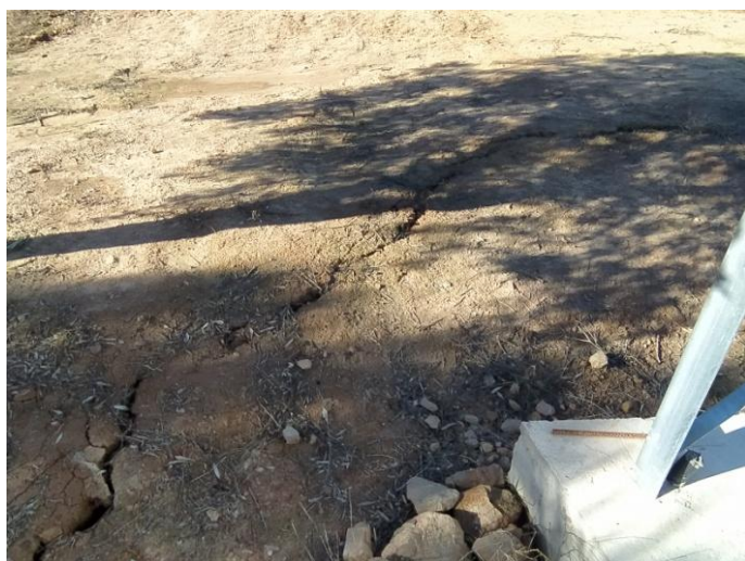
Imágenes 4 y 5: Apoyo AP66, grieta en apoyo al borde de terrazas de cultivo.
