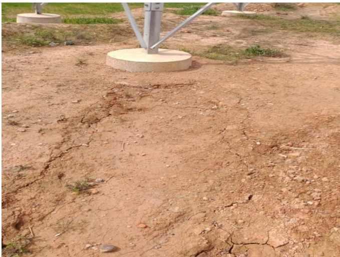
Imágenes 8 y 9: Apoyo AP76, hundimiento del suelo situado en el entorno de la base del apoyo.
